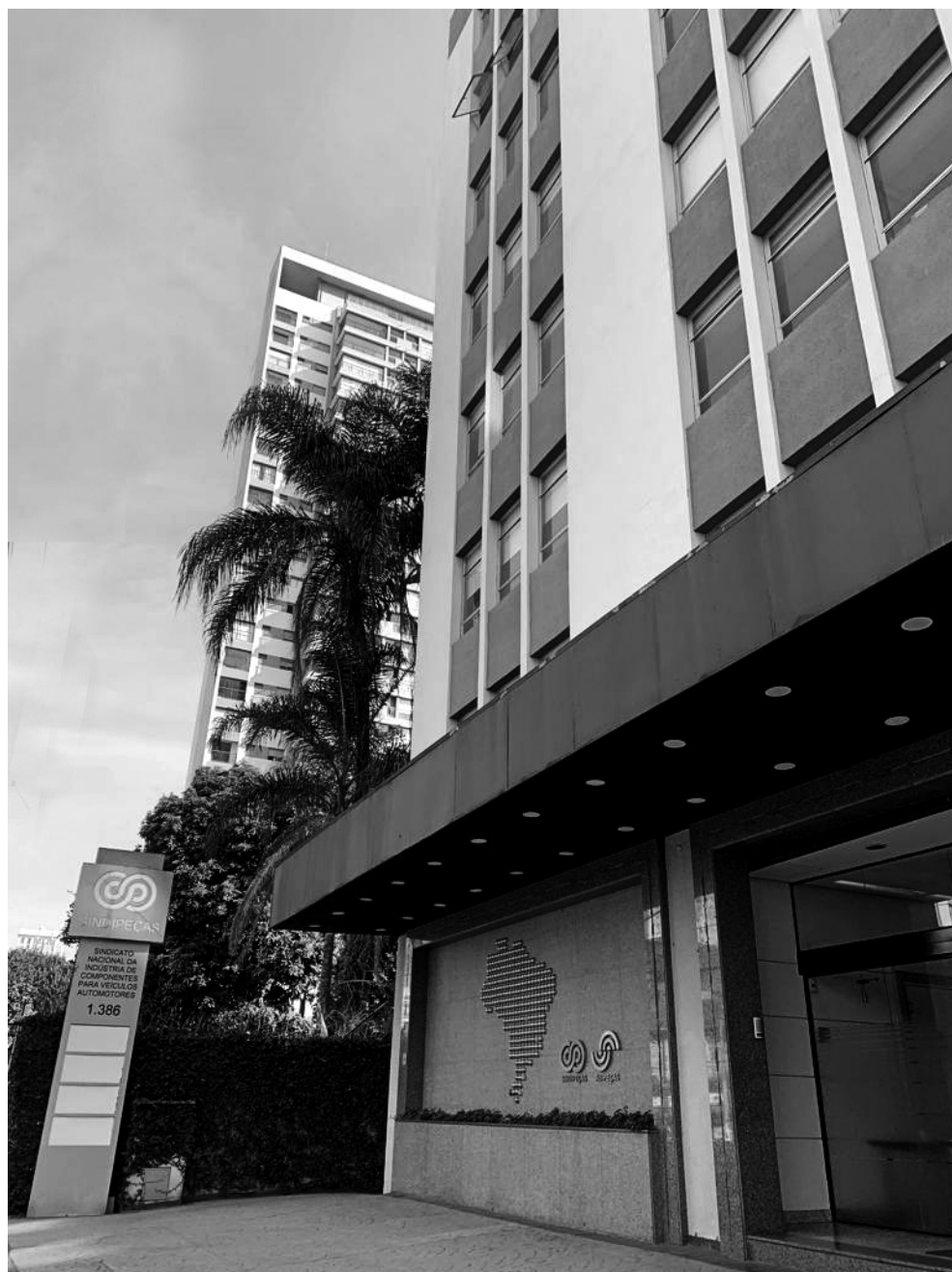
Parte da fachada do Edifício Sindipeças, na Av. Santo Amaro, nos anos 2000
